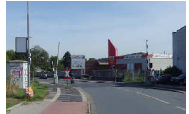
Bahnübergang Baerler Straße
