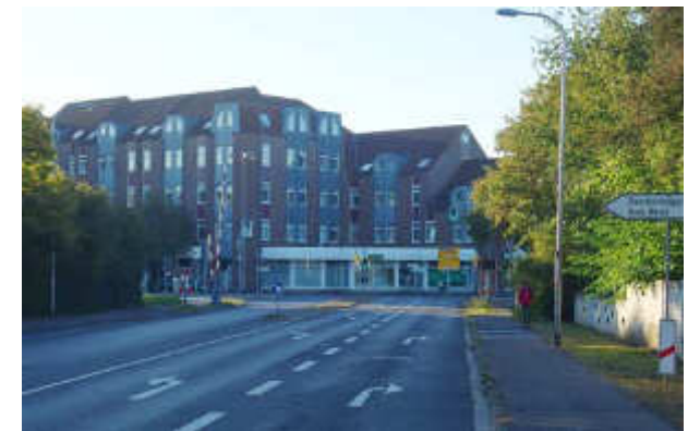
Bahnübergang Repelener Straße
