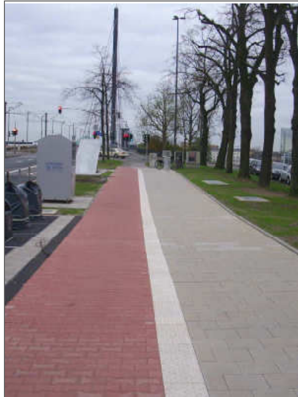
Bild 4-4: Getrennter Fuß- und Radweg
